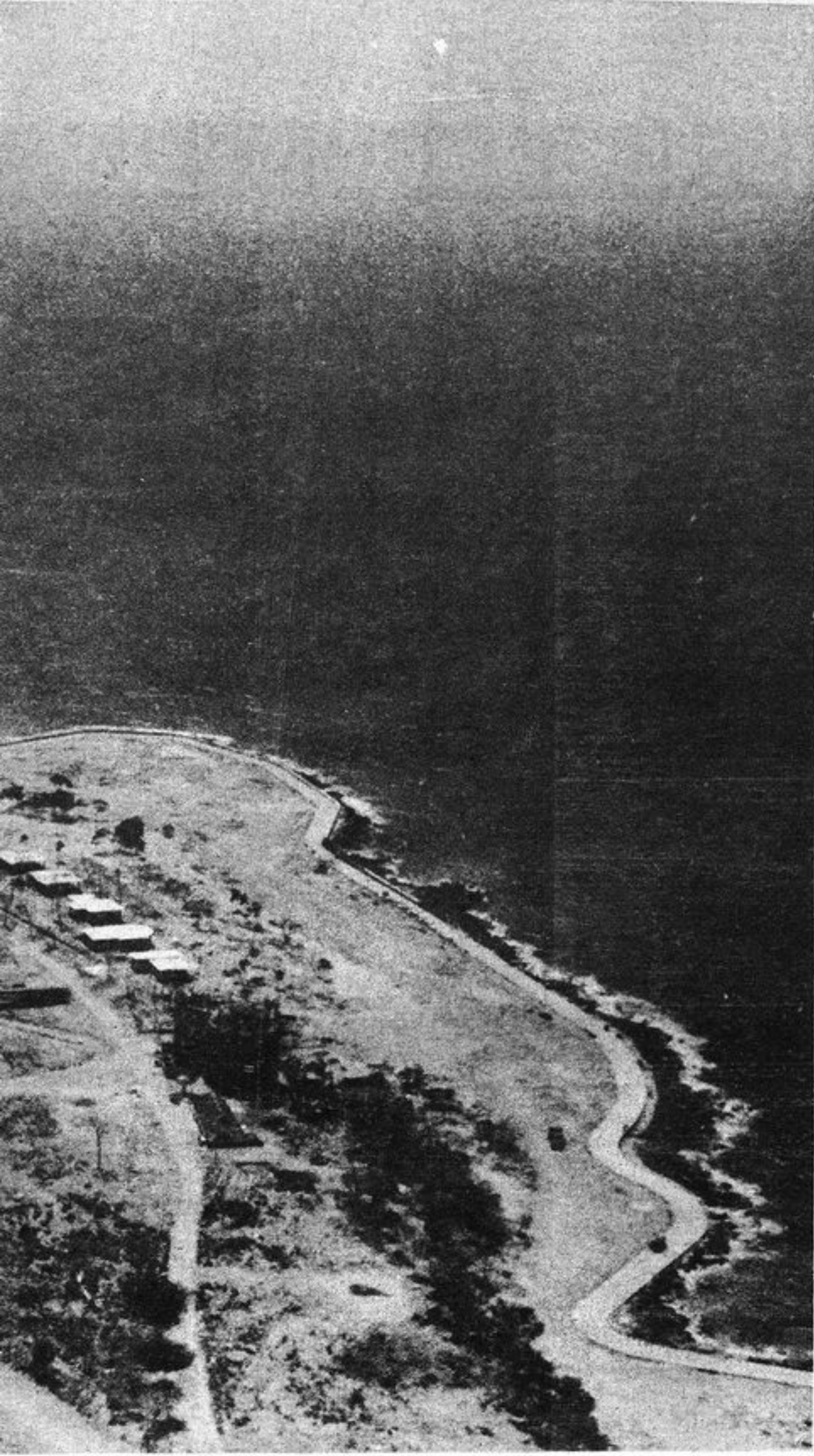
Esta Playa Girón, era uno de los puntos más inhóspitos de la Isla. La Revolución construyó este centro turístico pero no para los mandados por Mr. Kennedy.
